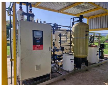
Volkswagen Argentina las lleva a cabo en sus Centros Industriales de Pacheco y Córdoba. En Pacheco puso en marcha una solución para el tratamiento del efluente generado en el proceso de limpieza de robots en la nueva planta de Pintura. En Córdoba incorporó una nueva etapa de filtrado en su Planta de Tratamiento de Efluentes que permite recuperar hasta 80 m<sup>3</sup> de agua por día.
