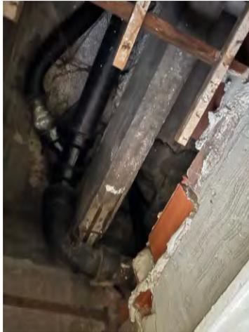
Se observa desprendimiento de recubrimientos con exposición de armaduras corroídas, en algunos casos como el de la última fotografía, la exposición de las armaduras se debe a una incorrecta colocación del caño de desagüe, dado que para permitir su curva, fue picado el fondo de la viga de hormigón.
