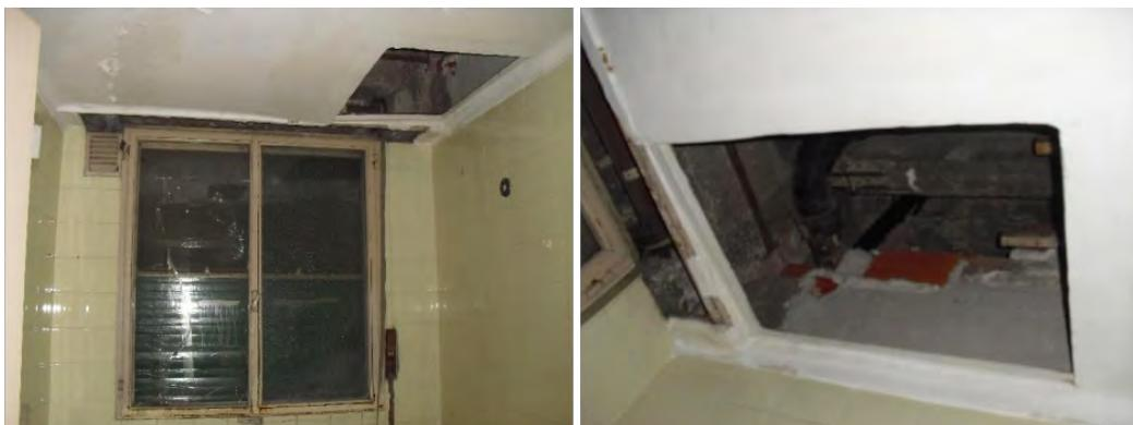
Pérdida de recubrimiento de las armaduras en viga (Baño de Habitación 27, Planta Primera)
