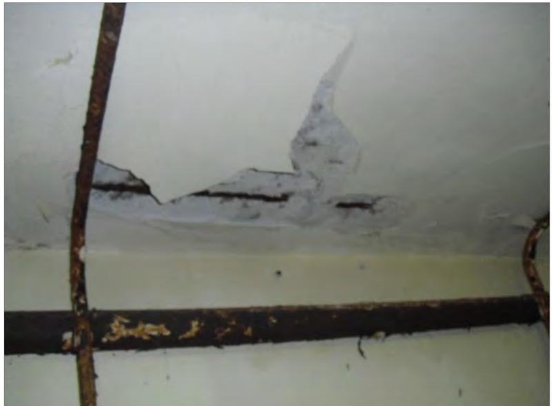
Pérdida de recubrimiento de las armaduras en losa, en Planta Sótano, bajo hall principal.
