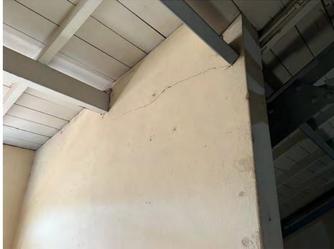
Se observan las fisuras en la mampostería, inmediatamente por debajo de la llegada de los cabios de madera de la cubierta.-
